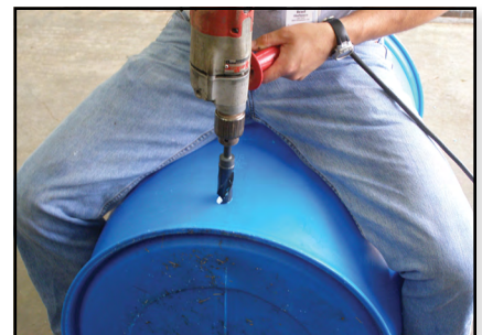
Perforación del orificio de desbordamiento.
