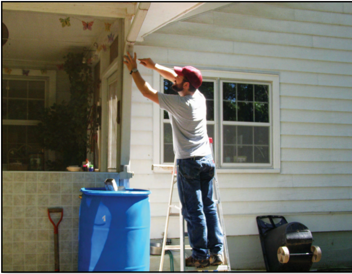
Hombre instalando un barril de lluvia en la casa.
