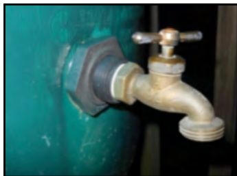
Canilla fijada a accesorio de conexión de salida.
