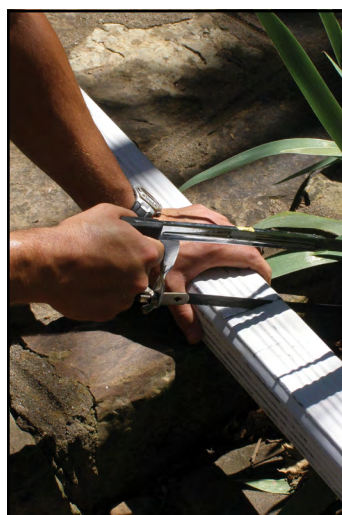
Cortar el canalón para colocar el nuevo codo.
